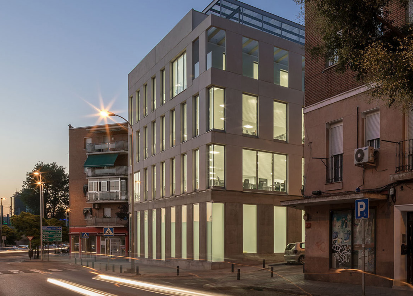
Edificio de oficinas en Vallecas // Madrid // 2017 // Francisco Domouso, Lorenzo Fernández-Ordóñez, Aránzazu de la Peña // Sorigué // Fotografía: Imagen Subliminal // Edificio de huecos estadísticos, con fachada a tres calles, construido con una estructura prefabricada portante de fachada de hormigón blanco. Esta estructura consigue que no haya pilares intermedios en las plantas, lo que permite el máximo aprovechamiento de las mismas a pesar de la irregular geometría del solar.
